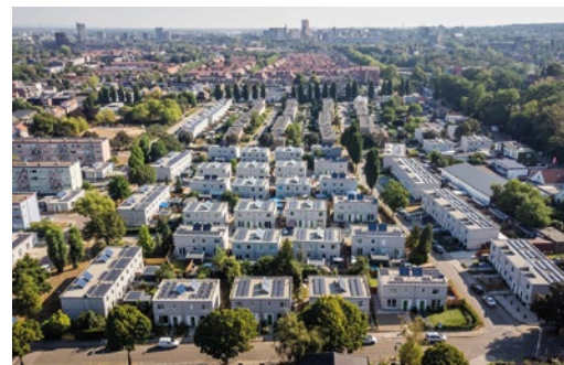
Dura Vermeer heeft in 3,5 jaar 220 verouderde woningen (links) vervangen door nieuwbouw (rechts).
